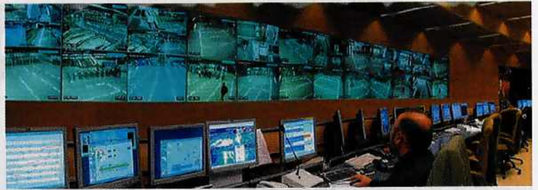
Centro de control de Metrosur
